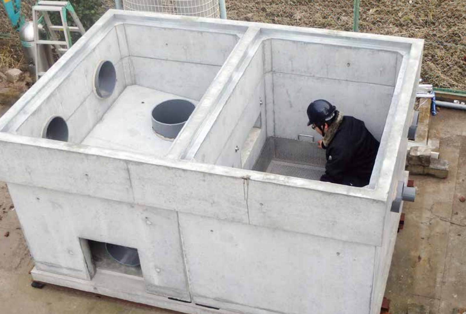
■大型浸透槽・貯留槽用ノンドスト■ 流入径φ300×2ヶ所
