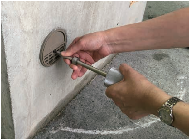
① 先端を取り出し口に差し込む
