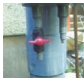
▲写真① オリフィスからは管理ボックス内の雨水を少しずつ排出する仕組みになっている
