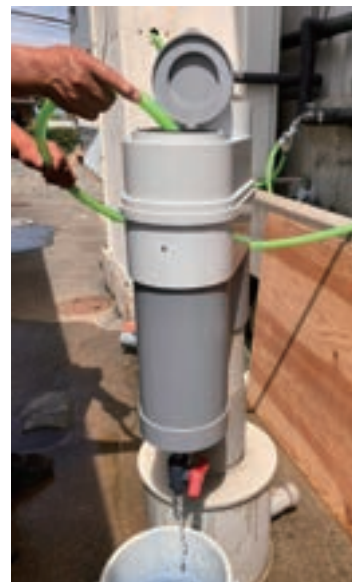
◀写真⑤ ドレンバルブを開いて塵埃を洗い流す
