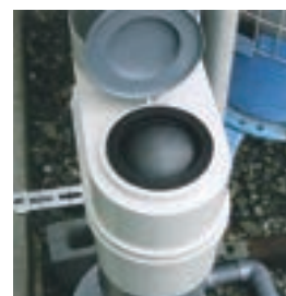
▲写真② フロートが上昇した状態
