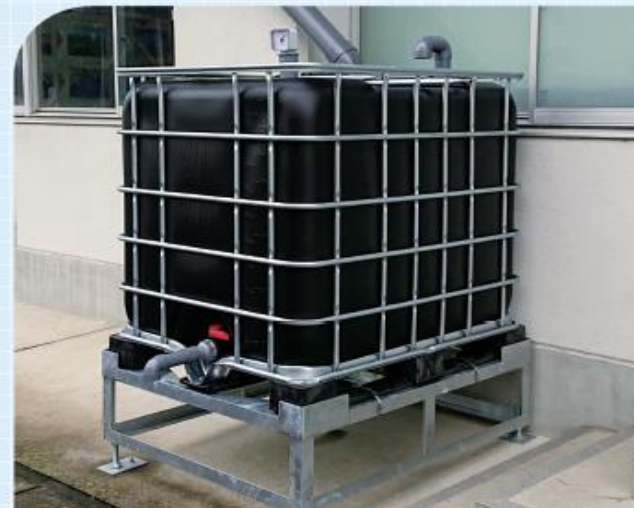
架台との併用： 排出バルブの下にバケツなどが入る高さになる
